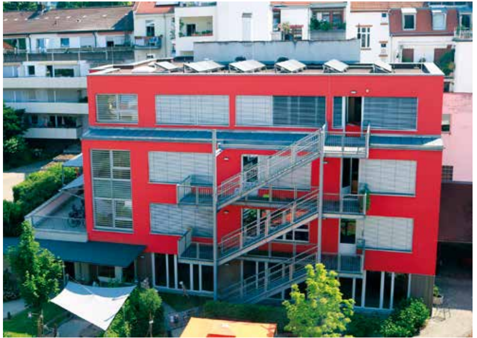
Wo früher ein Personalwohnheim des Altenpflegeheims St. Michael stand, wurde vor zehn Jahren das markante rote Gebäude für die Kinderkrippe errichtet.
